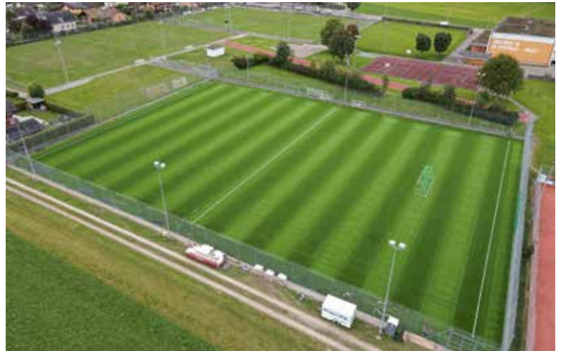
Der Allwetterplatz ist saniert und erneuert (Quelle: Stefan Sennhauser).
