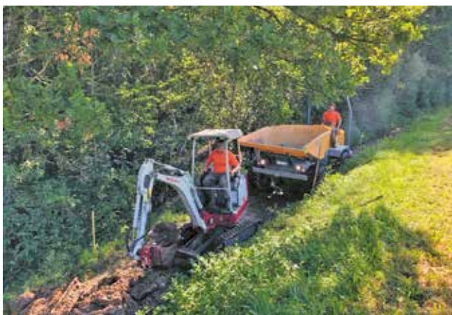
Sanierung Wanderweg Bütschwil
