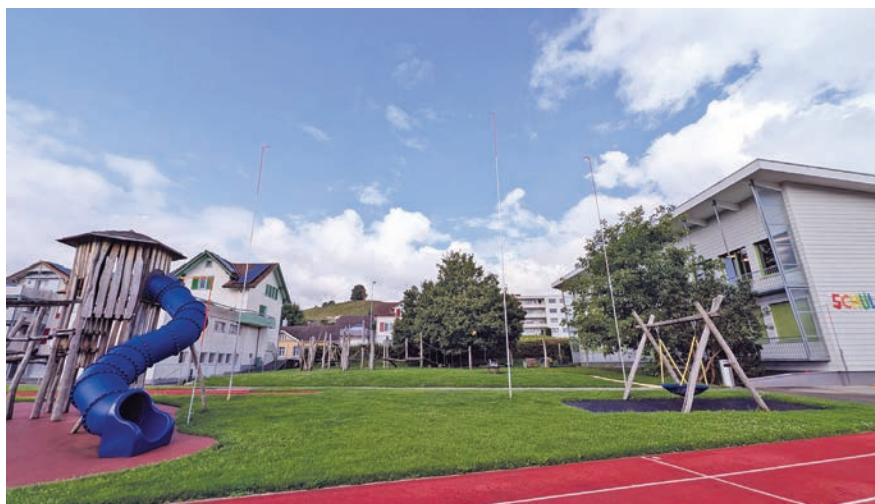
Die Visiere zum Bauprojekt auf dem Schulareal
